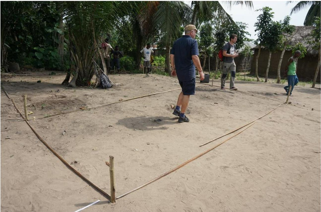
Figure 1 - Bornage de l'emplacement du container par l'équipe de Reusch Energietechnik à Gbandidi (source: Reusch / CIREG)
